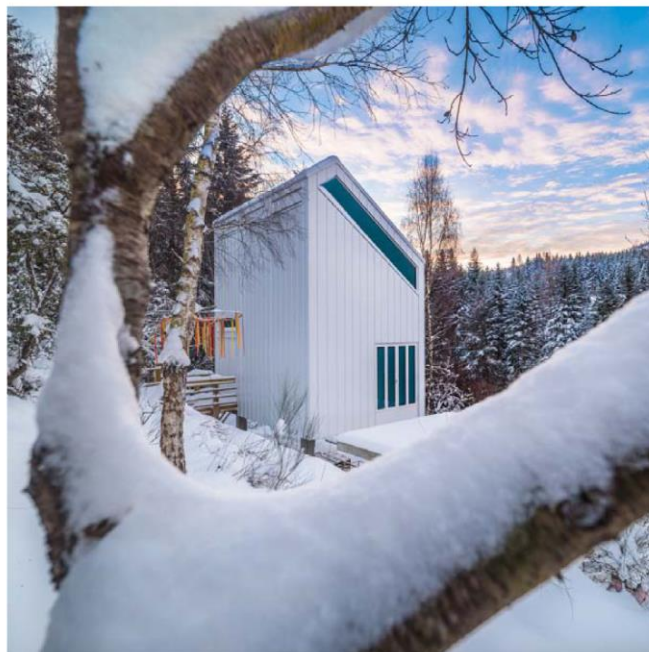
Galeria Sztuki w Lesie – elewacja zachodnia z trapezową szybą zespoloną o wymiarach 750x5390 mm (fot. Szymon Seweryn)
