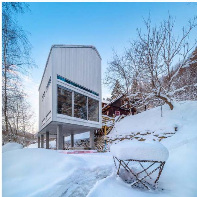
Galeria Sztuki w Lesie – elewacja wschodnia z szybą zespoloną o wymiarach 399x4471 mm (fot. Szymon Seweryn)
