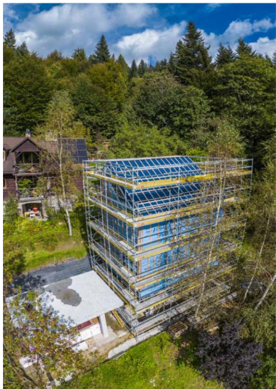
Galeria Sztuki w Lesie – pierwszy etap w trakcie budowy (fot. Szymon Seweryn)
